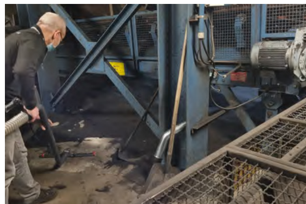
Aspiration de sable sous convoyeur
